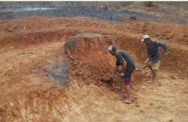
Foto 2 – Escavação manual da cisterna
