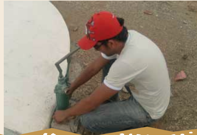
Foto 19 – Instalação da bomba manual para retirada da água
