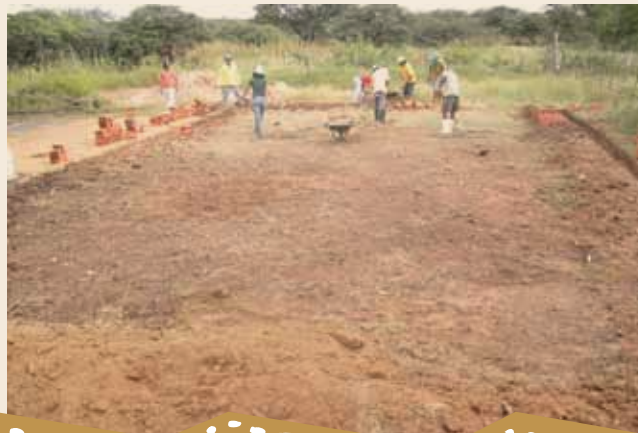
Foto 21 – Mutirão para preparar o calçadão
