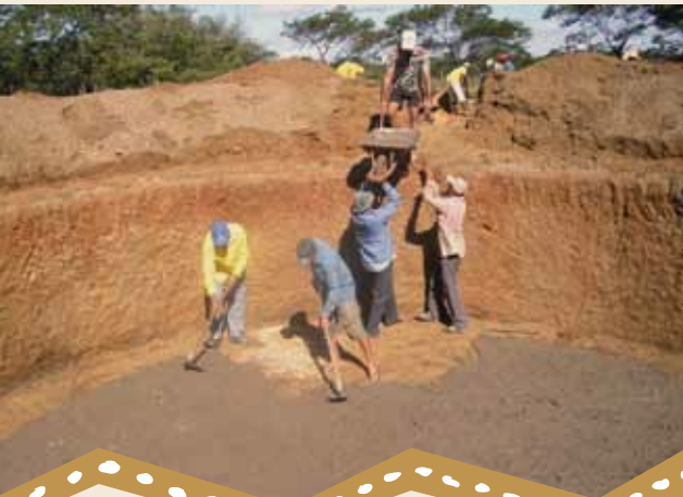
Foto 6 – Confeção do piso do fundo da cisterna
