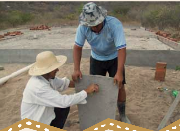
Foto 9 – Detalhe do pedreiro furando a placa
