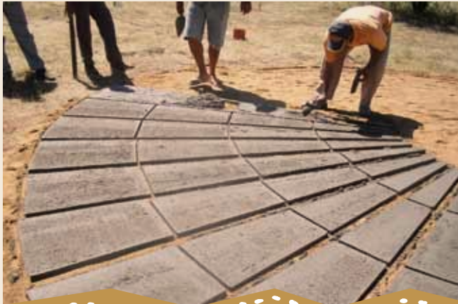
Foto 5 – Confeção das placas do teto
