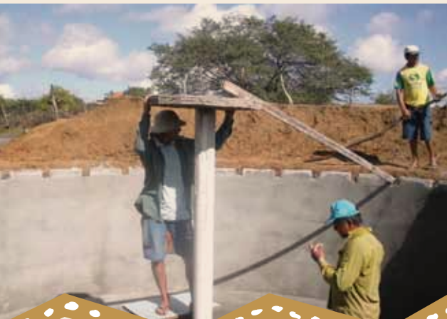
Foto 16 – Colocação da cora central
