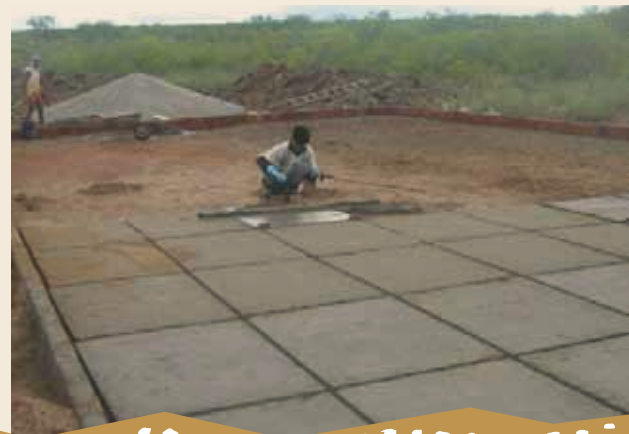
Foto 23 – Construção do calçadão com placas de cimento
