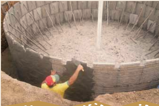
Foto 14 – Reboco externo da cisterna
