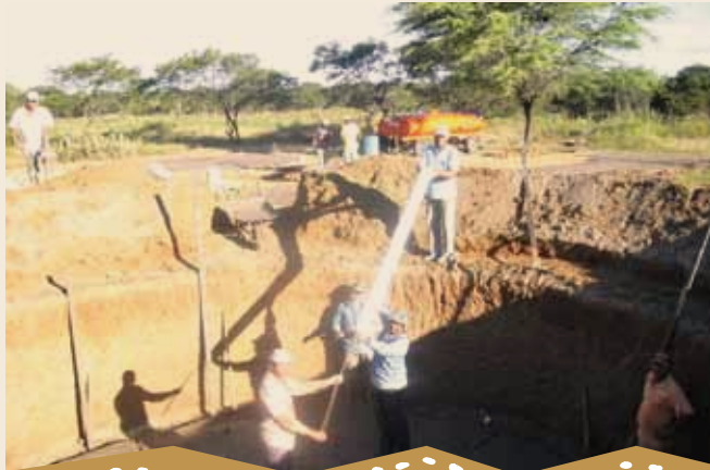
Foto 10 – Colocação da coluna central, feita de cano
