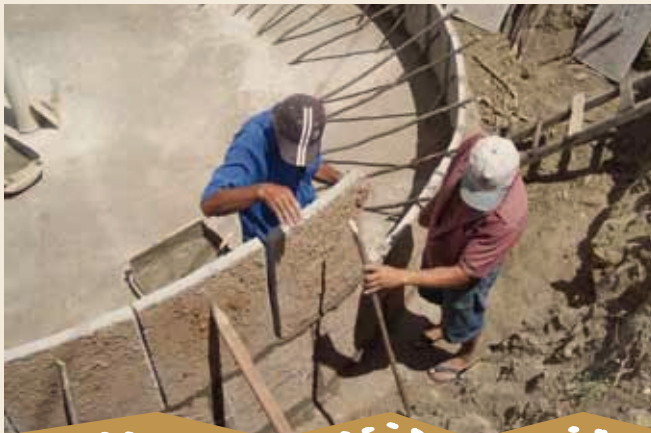
Foto 8 – Construção da parede da cisterna
