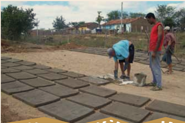
Foto 3 – Confeção das placas da parede
