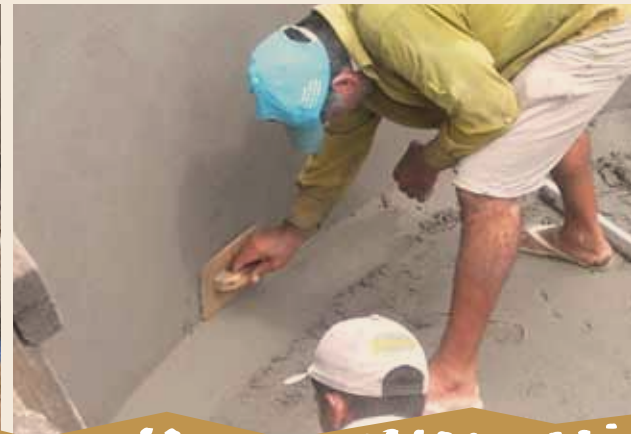
Foto 15 – Reboco interno do fundo da cisterna
