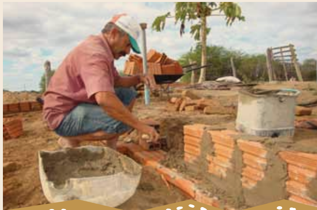
Foto 22 – Pedreiro construindo o muro do calçadão
