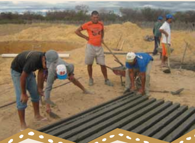
Foto 4 - Confecções das vigas do teto da cisterna.
