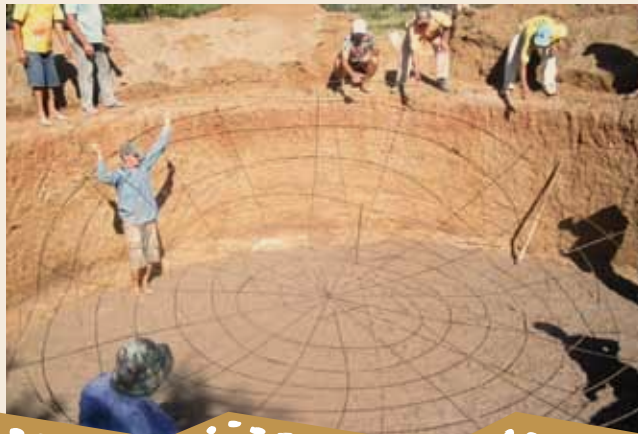
Foto 7 – Fixação da grade no piso
