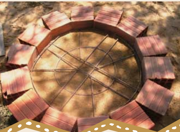
Foto 12 – Armação de ferro do pião central
