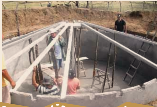
Foto 17 – Colocação das vigas
