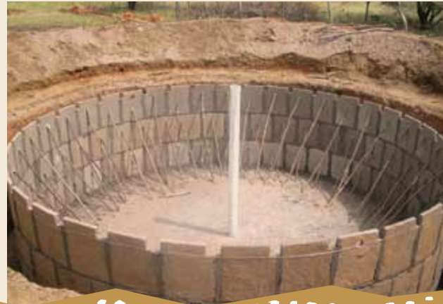
Foto 11 – Detalhe da coluna central pronta
