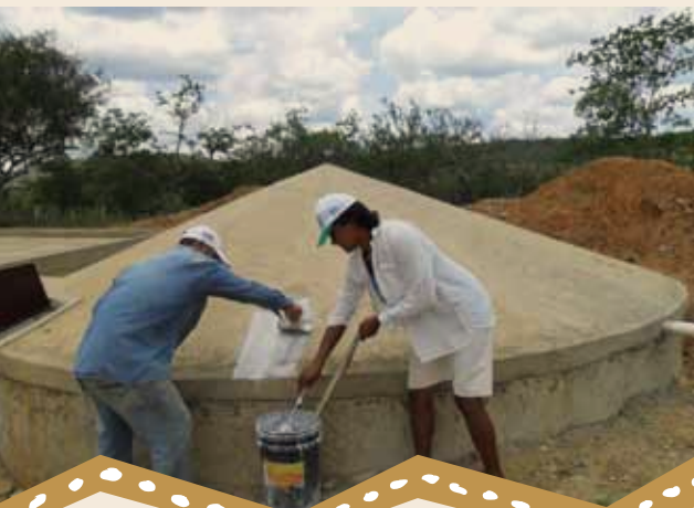
Foto 20 – Pedreiro pintando a cisterna
