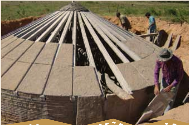
Foto 18 – Construção do teto da cisterna
