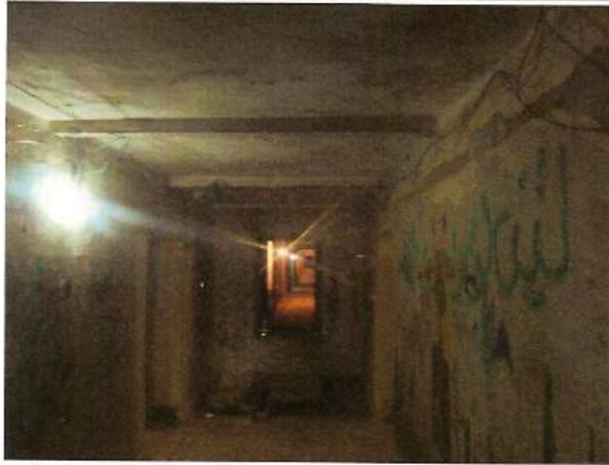
Porão. Vista interna do porão. Apoio estrutural em madeira nas paredes e teto.
