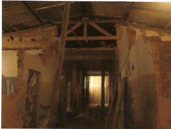
Segundo pavimento. Reconstrução do telhado. Detalhe para estrutura da tesoura em madeira reconstruída e telhas em amianto.
