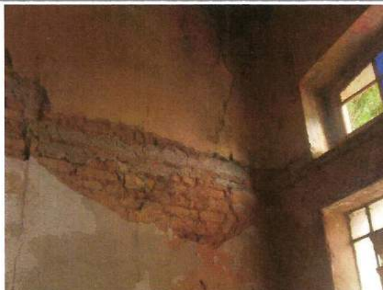
Vista da parte interna do arco da fachada frontal. Tratamento das principais trincas e recomposição da alvenaria.
