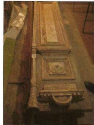
Segundo pavimento. Detalhe para uma das folhas pertencentes a porta principal de acesso da fachada principal. Em processo de restauro.
