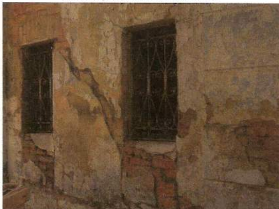
Detalhe da fachada frontal. Tratamento das principais trincas na alvenaria.
