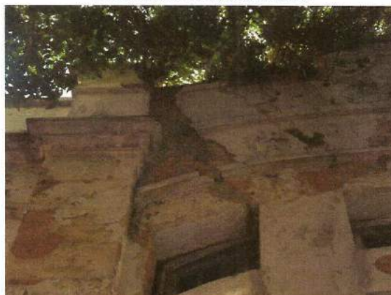
Fachada frontal. Tratamento das principais trincas na alvenaria da fachada e do arco.
