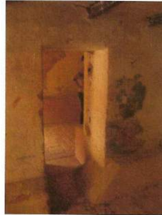
Porão. Abertura dos vãos de acesso às salas.
