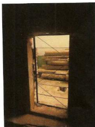
Primeiro pavimento. Abertura dos vãos das portas com fechamento em gradil do primeiro pavimento e porão.
