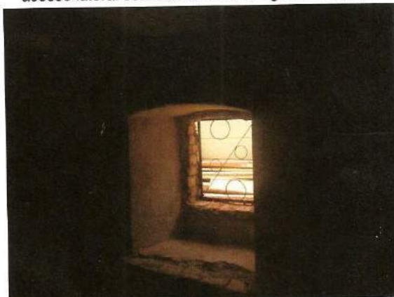
Primeiro pavimento. Abertura dos vãos das janelas com fechamento em gradil do primeiro pavimento e porão.
