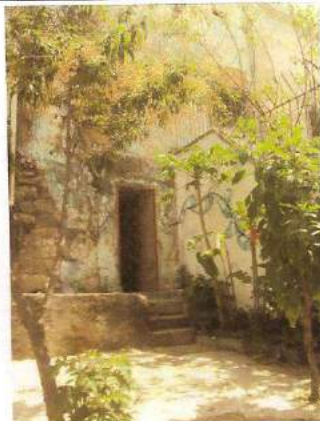
Fachada lateral esquerda. Abertura do vão principal para acesso lateral com fechamento em gradil metálico.
