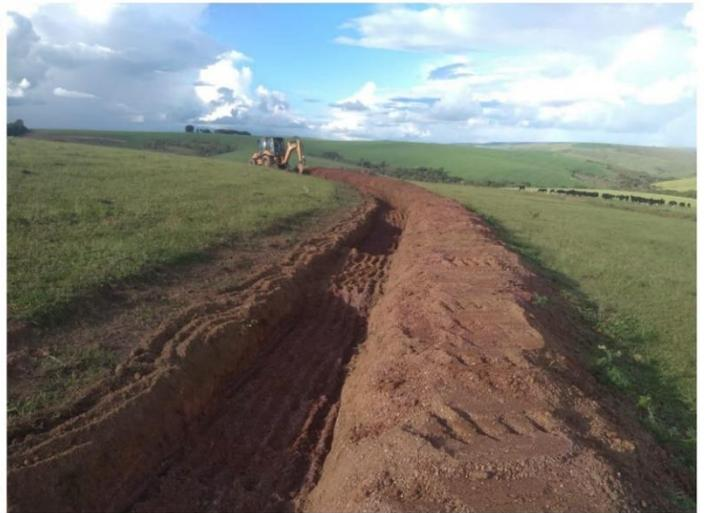
Fig. 18 – Curvas de Nível com Cochinhos construídas em Sacramento/MG, após capacitação realizada pelo operador de retro Uoxiton, de Lassance-MG.
