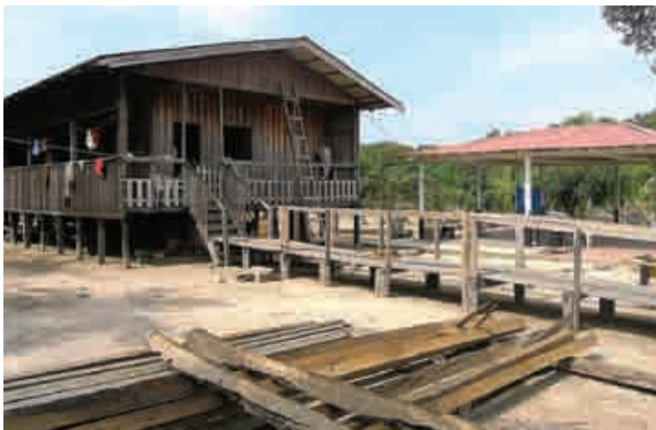
FIGURA 2. PEÇAS DE MADEIRAS UTILIZADAS NA CONSTRUÇÃO DA PONTE, NA COMUNIDADE SANTA LUZIA DO BUIUÇUZINHO.
