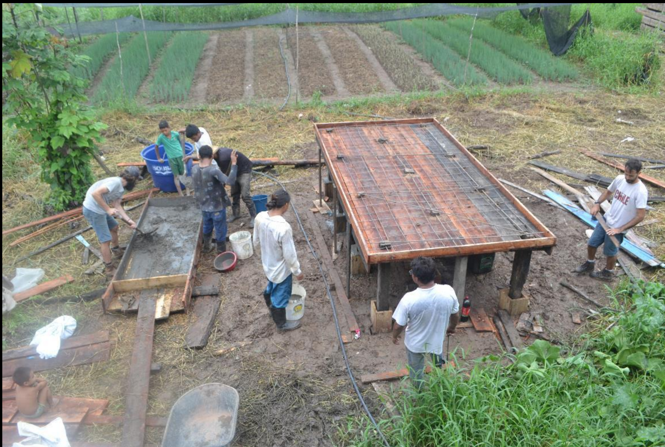
Obra de construção da Fossa Alta Comunitária. Participação ativa dos moradores, facilitando o processo de apropriação da tecnologia social.
