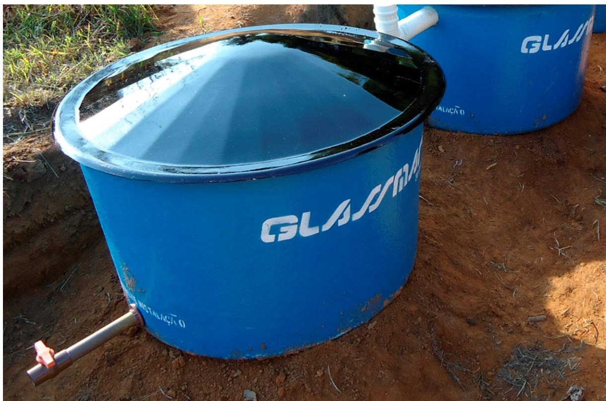
Figura 9. Saída da 3ª caixa com tubo e registro de 50 mm. (Foto: Renato Marmo)
