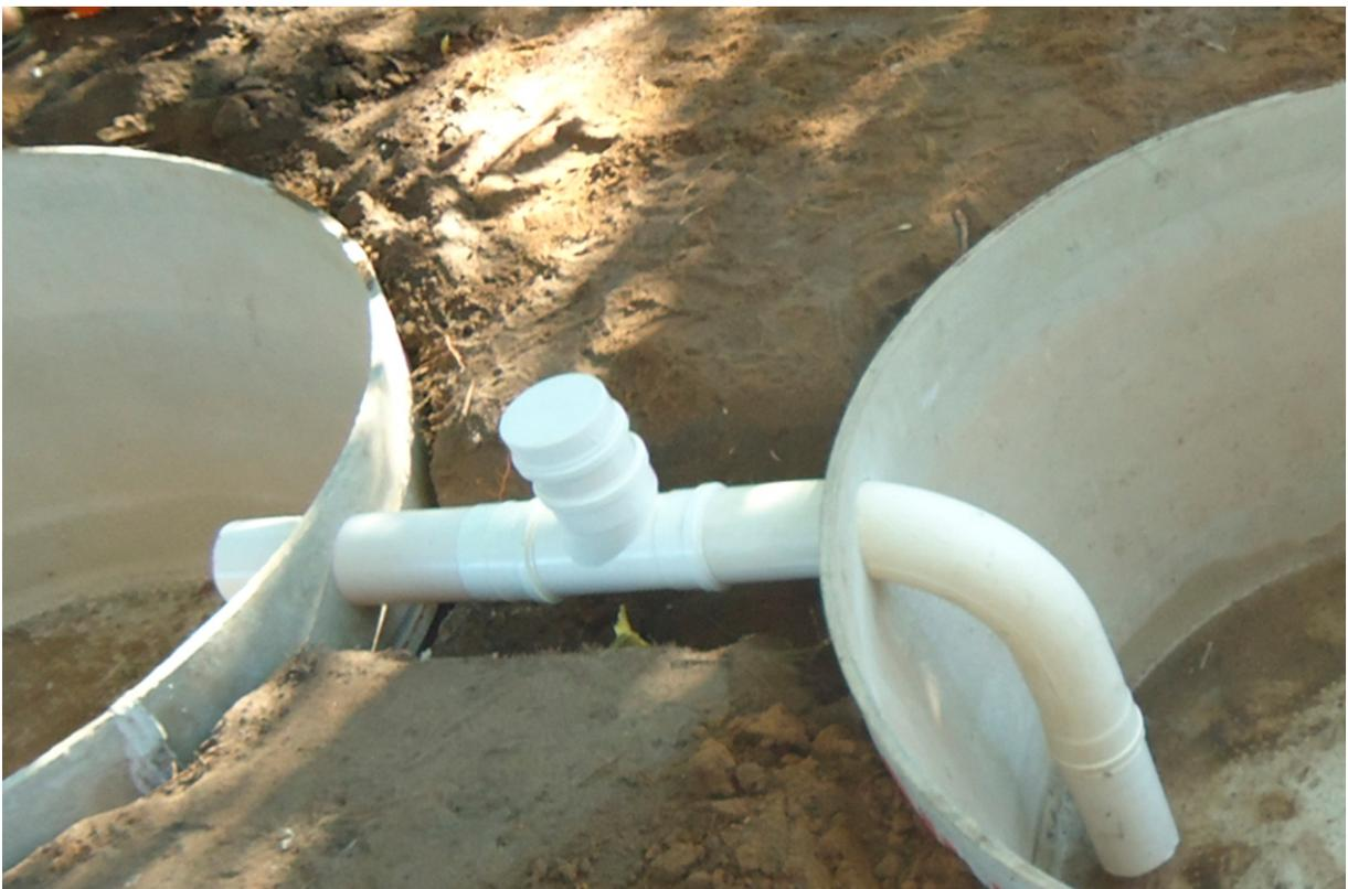
Figura 7. Detalhes do uso de tê comum + CAP 100 mm entre as caixas. (Foto: Renato Marmo)
