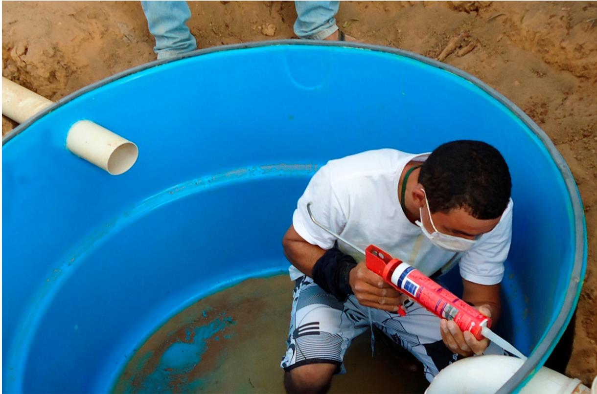
Figura 8: Aplicação de silicone na interface caixa e tubo PVC. (Foto: Renato Marmo)
