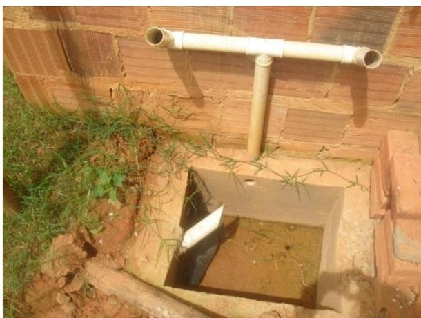
A caixa de passagem (Figura 2.12) utilizada é pré-moldada em PVC (Policloreto de vinila), marca Tigre®, nas dimensões (0,25 x 0,23 x 0,5 m).
