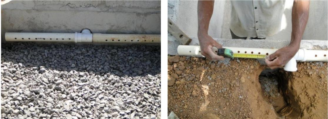
O material suporte utilizado nas *wetlands* foi a brita nº 1, material este de granulometria maior que a normalmente utilizada, como a areia e brita zero, de forma a evitar a colmatação prematura do meio suporte, diminuindo, assim, a manutenção do sistema e evitando a formação de escoamento superficial.
