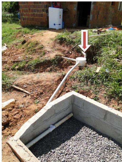
Na unidade WC-FH, o modelo de dimensionamento utilizado baseou-se na cinética de primeira ordem e fluxo em pistão (Equação 2.8), conforme apresentam Conley *et al.* (1991):
