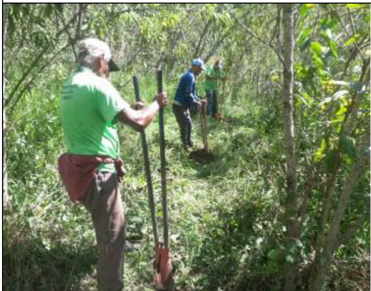
Implantação da cerca de isolamento da área - Brazópolis Bairro: Sertãozinho
