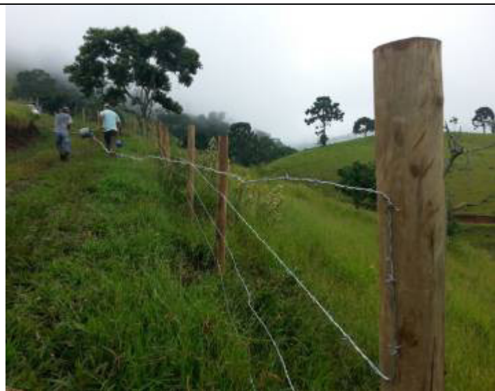
Implantação da cerca de isolamento da área - Gonçalves Bairro: Novo Mundo
