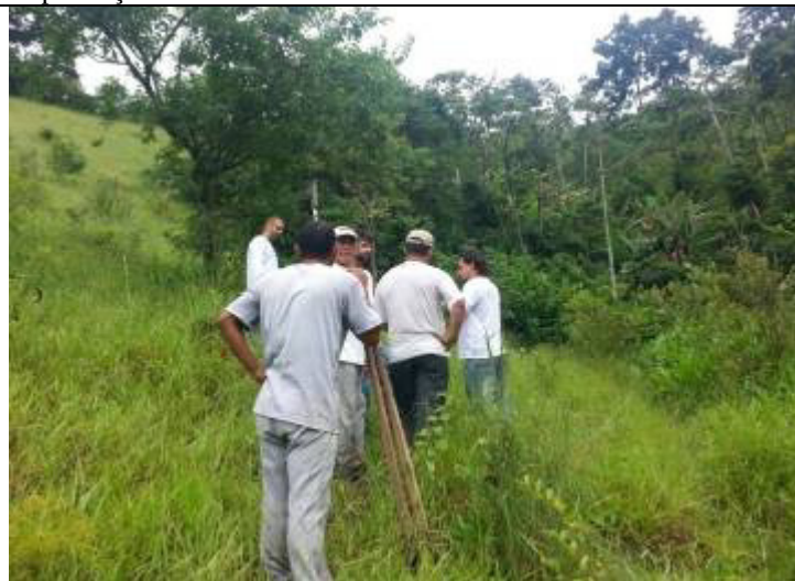
Implantação da cerca de isolamento da área - Brazópolis Bairro: Luminosa
